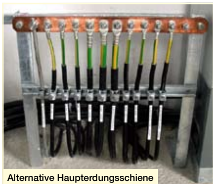
Alternative Haupterdungsschiene
