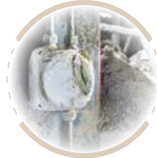
KF系列: IP 66 / IP 67 / IP 69 全天候防护, 适合无任何保护的户外安装, 带或不带接线端子, 有公制敲落孔
