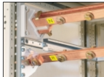
Beispiel Schaltanlage nach Umrüstung auf ein TN-S-System: Gelb-grüne Brücke ist entfernt, PEN-Leiter in N umgezeichnet (siehe auch Seite 3)!
