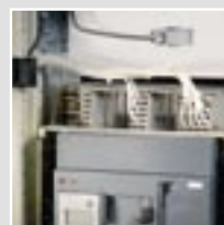
Lichtsensor zur optischen Erfassung des Lichtbogens.
