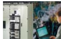
Typgeprüfte Niederspannungs-Schaltanlagen bis 7300 A, IP 30-65
