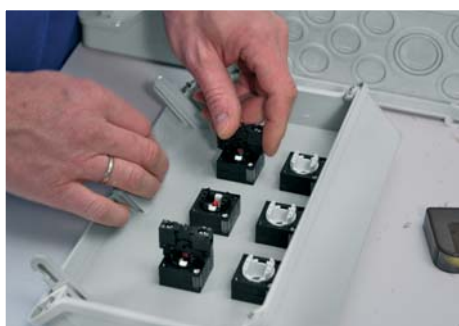
Einbaugeräte einbauen und verdrahten.
