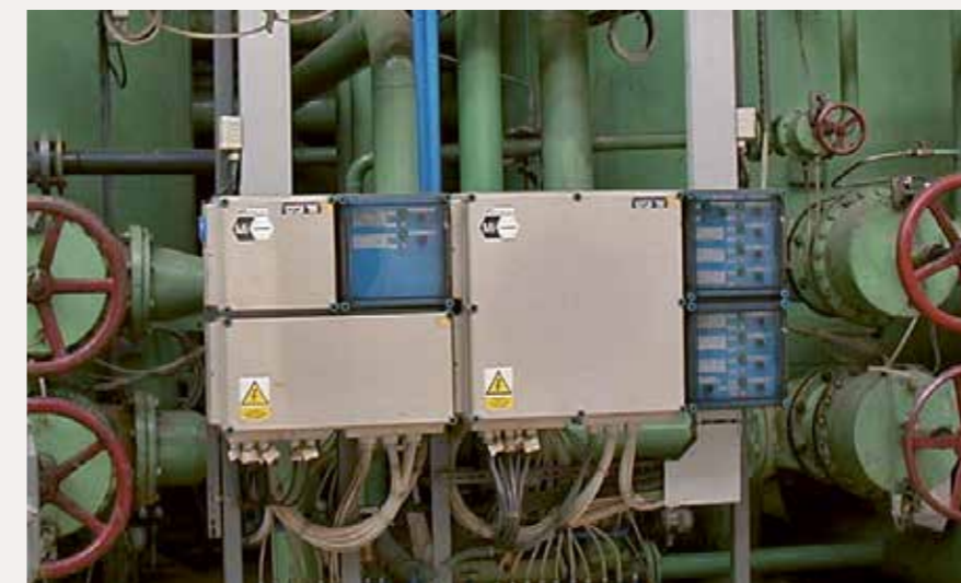
Mi-Verteiler in der chemischen Industrie
