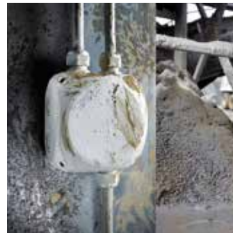
KF forgreningsdåser: IP 66 / IP 67 / IP 69 „Vejrbestandig“, til ubeskyttet udendørs installation udslagsblanketter
