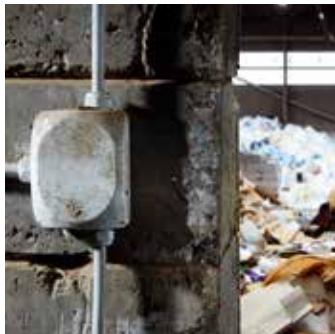
DK forgreningsdåser: IP 66 til normale omgivelserforhold og beskyttet udendørs installation
