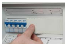
Afdækning for ubenyttede DIN-skinne åbninger
