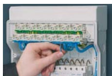
FIXCONNECT® plug-in klemmeteknologi
