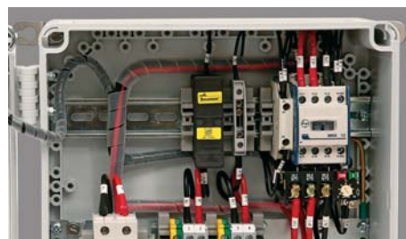
DIN-skiner til udstyr eller klemmer med clip onmontering
