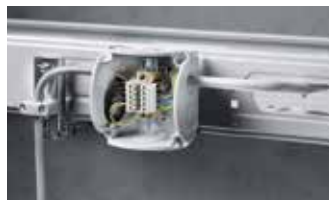
mit Reihenklammern
