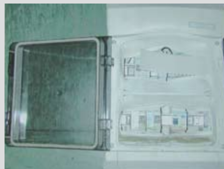
■ Kúszóáram a készülékben a belső tér szennyeződése vagy nedvességtartalma miatt
