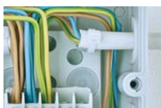
Dragavlastning med ett buntband i botten
