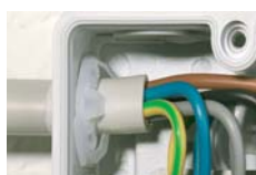
Dragavlastning med en avlastningsring för kablar
