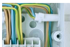
Dragavlastning med ett buntband i botten
