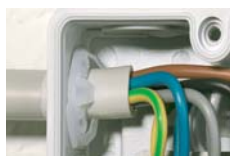
Dragavlastning med en avlastningsring för kablar
