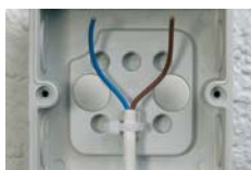
Dragavlastning med ett buntband i botten
